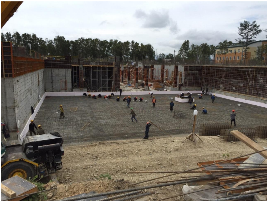
Рис.1. Заливка фундамента и наружных стен высотой 4 800 мм
