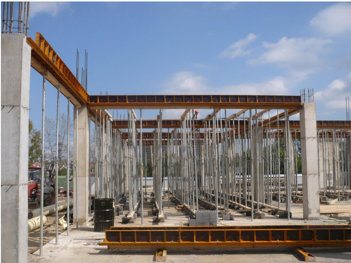
Рис.9. Применение опалубки в строительстве блочных фундаментов
