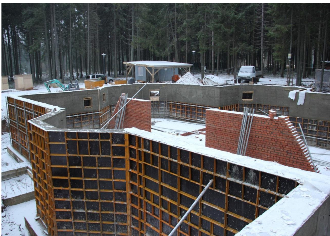
Рис. 12. Применение опалубки в строительстве коттеджного дома
