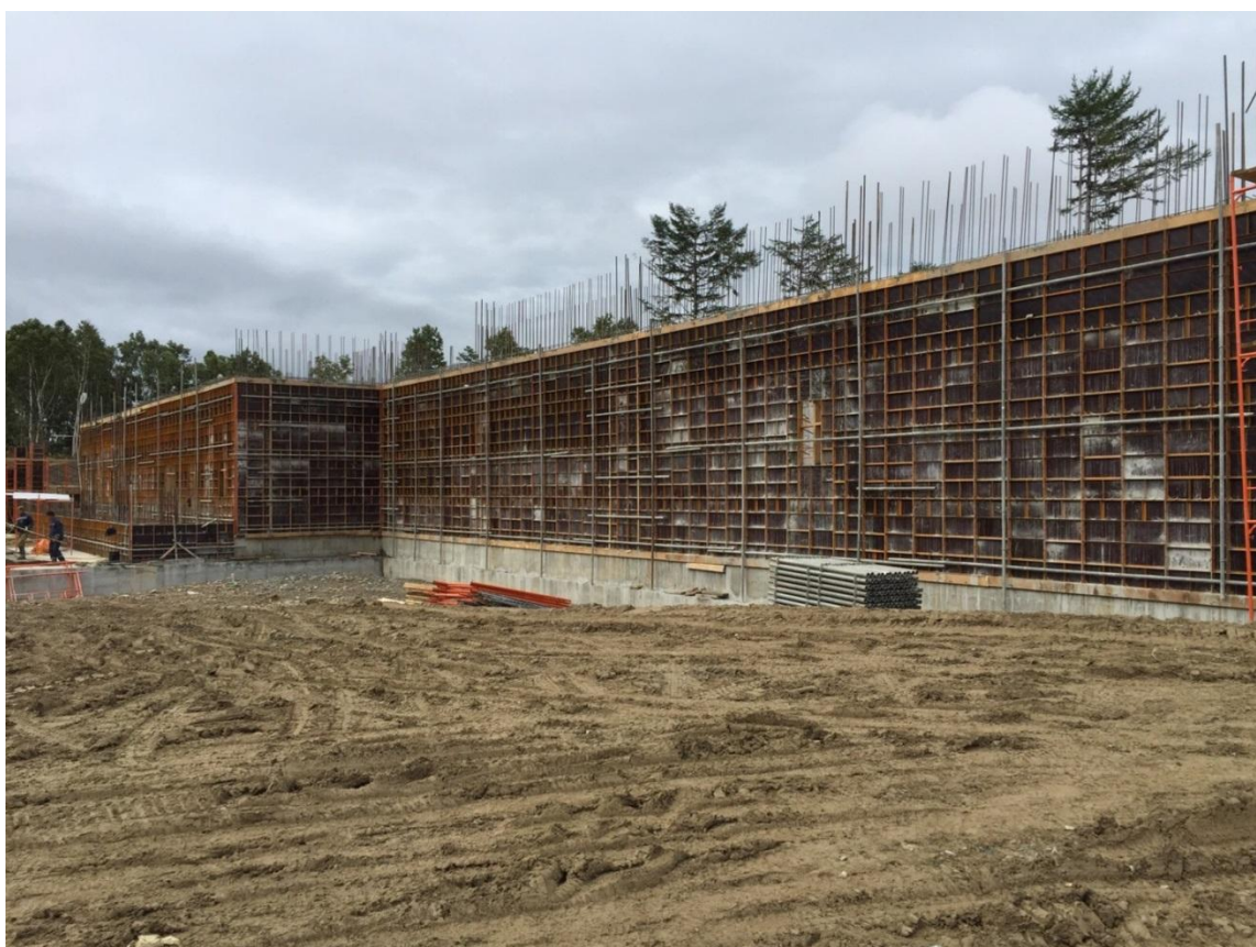
Рис.2. Заливка фундамента и наружных стен высотой 4 800 мм
