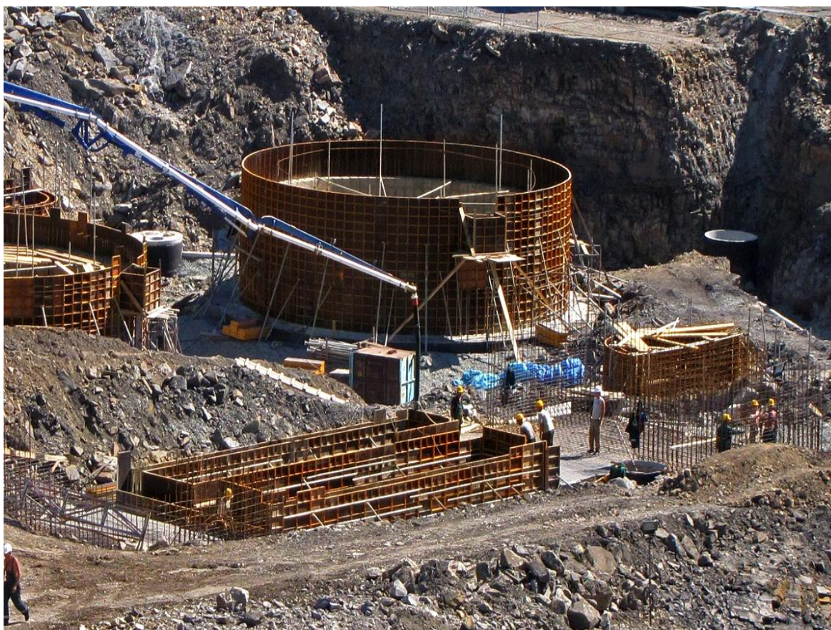
Рис.6. Применение опалубки в строительстве цилиндрических форм высотой 4 500 мм
