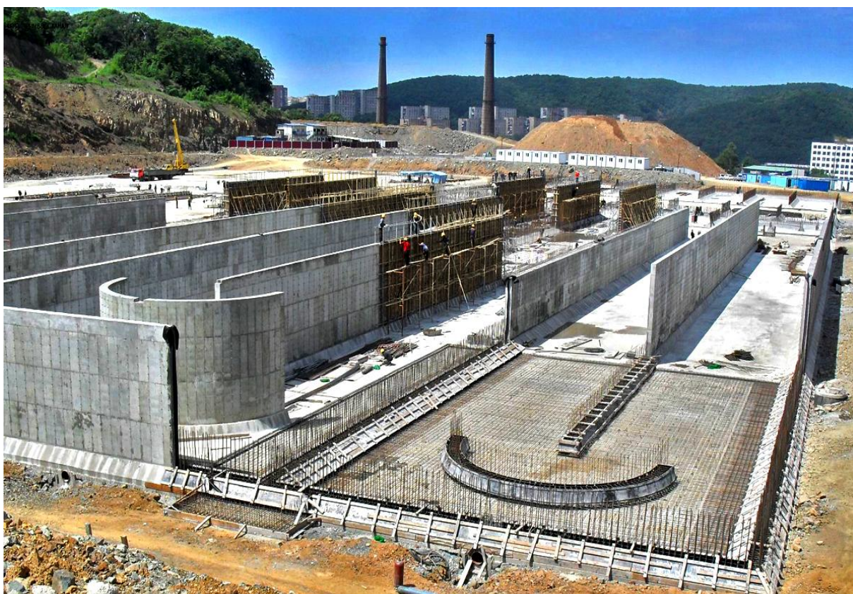
Рис.4. Применение опалубки в строительстве радиусных стен высотой 5 000 мм
