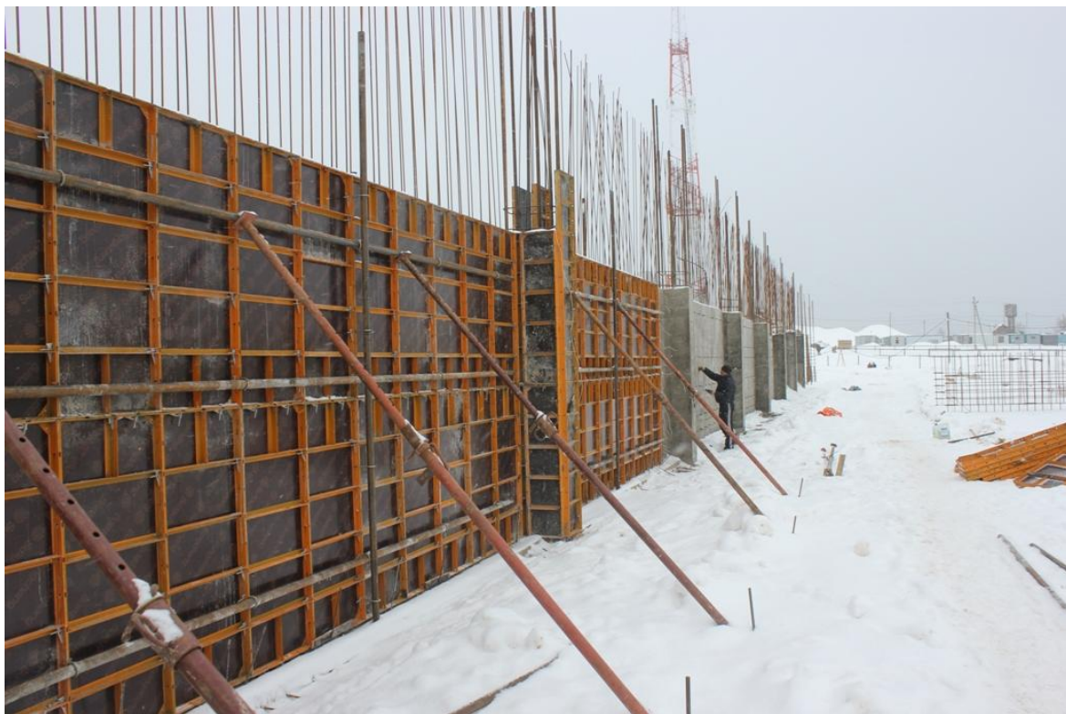
Рис. 11. Применение опалубки в строительстве наружных стен высотой 6 000 мм
