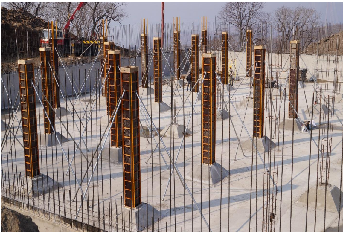
Рис.5. Применение опалубки в строительстве колонн высотой 4 700 мм
