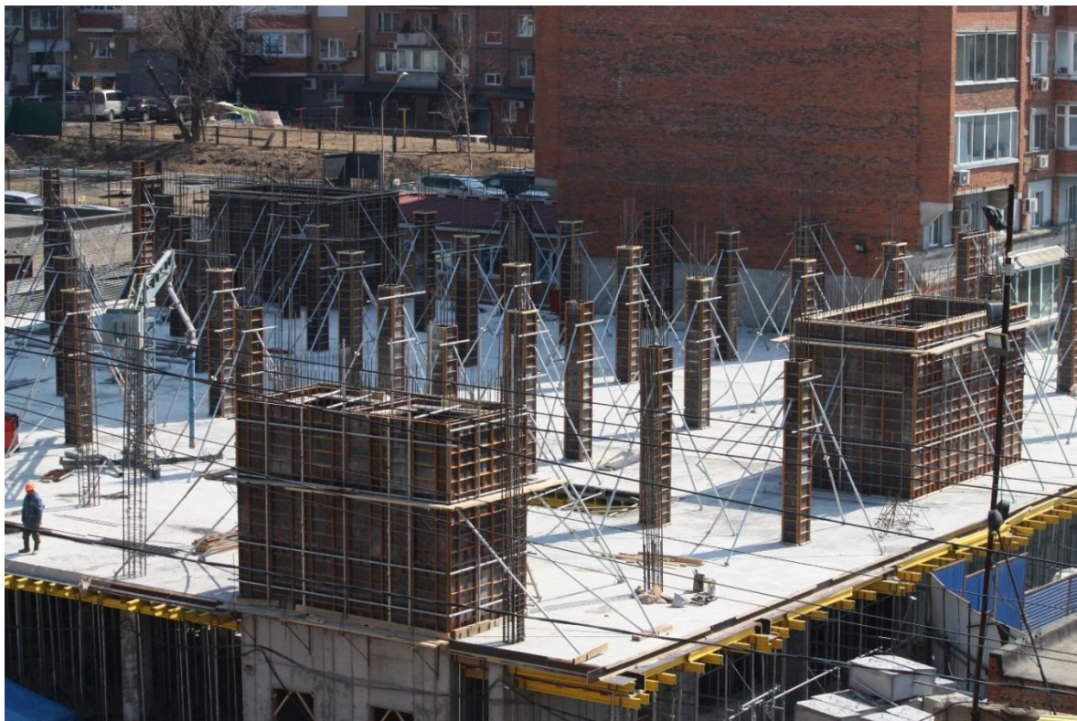
Рис.3. Применение опалубки в строительстве 18 этажного дома
